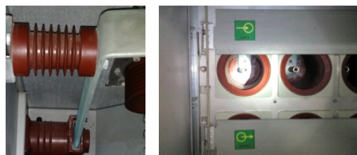
图2 受潮氧化的铜排和静触头
