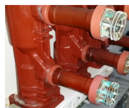
图1 受潮氧化的断路器触头
